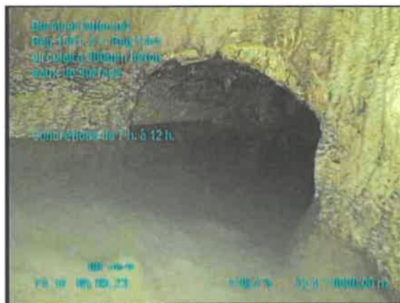
7, 00:00:02, 0.50m Concrétions de 7 h. à 12 h.
