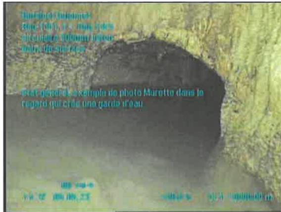
5, 00:00:05, 0.20m Etat général, exemple de photo / Murette dans le regard qui crée une garde d'eau
