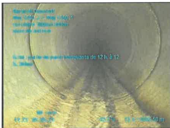
3, 00:00:54, 2.50m Éclat / partie de paroi manquants de 12 h. à 12 h., Début
