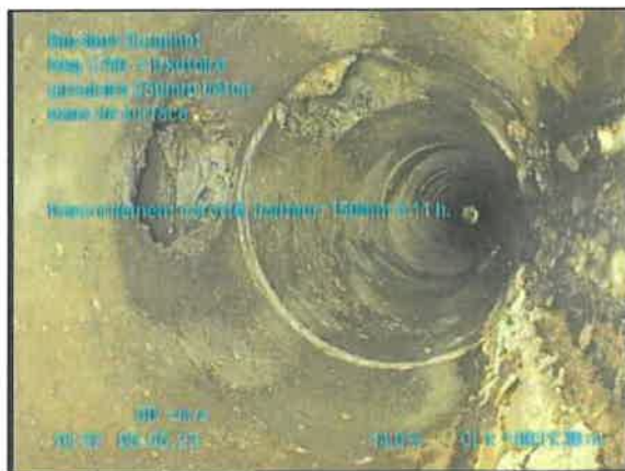
27, 00:10:33, 31.30m Raccordement caroté, hauteur: 150mm à 11 h.
