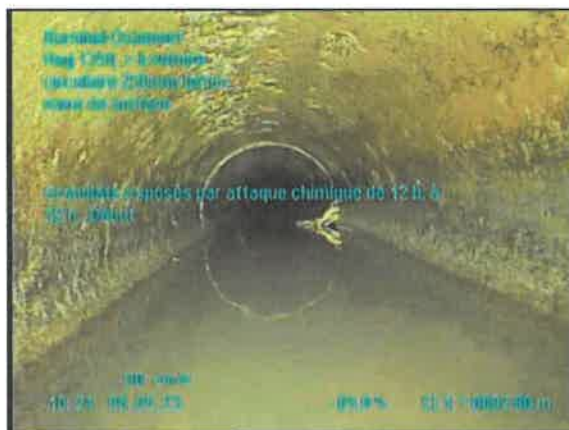
7, 00:01:20, 2.80m Granulats exposés par attaque chimique de 12 h. à 12 h., Début
