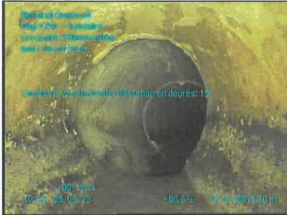
13, 00:04:00, 11.70m Courbure vers la droite, déviation en degrés: 15°
