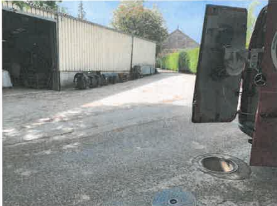
1, 00:00:00, 0.00m Début de la canalisation
