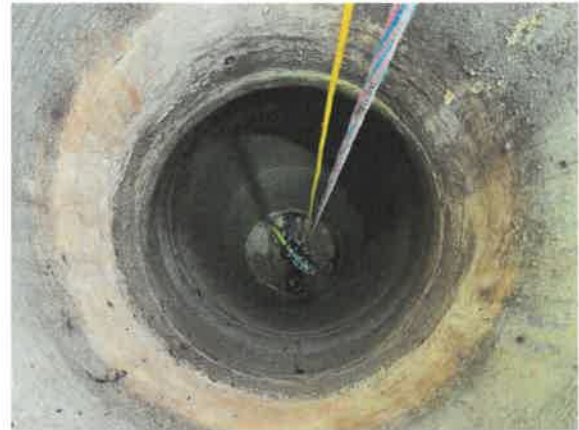
2, 00:03:08, 0.00m Début de la canalisation
