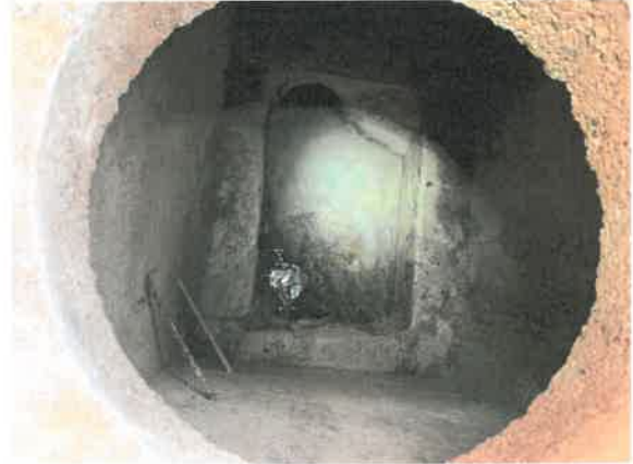
2, 00:00:00, 0.00m Début de la canalisation
