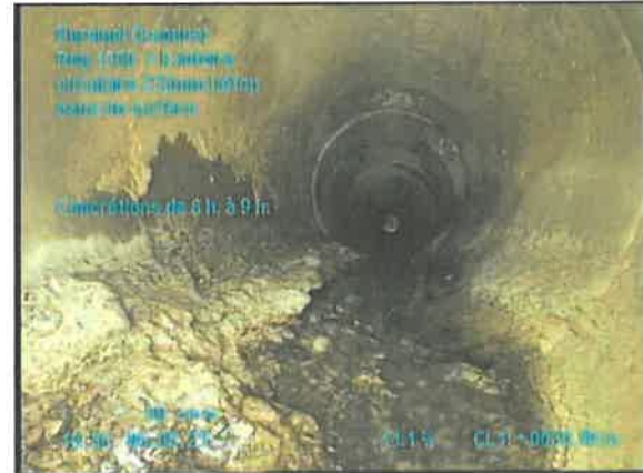
26, 00:10:03, 30.10m Concrétions de 6 h. à 9 h.
